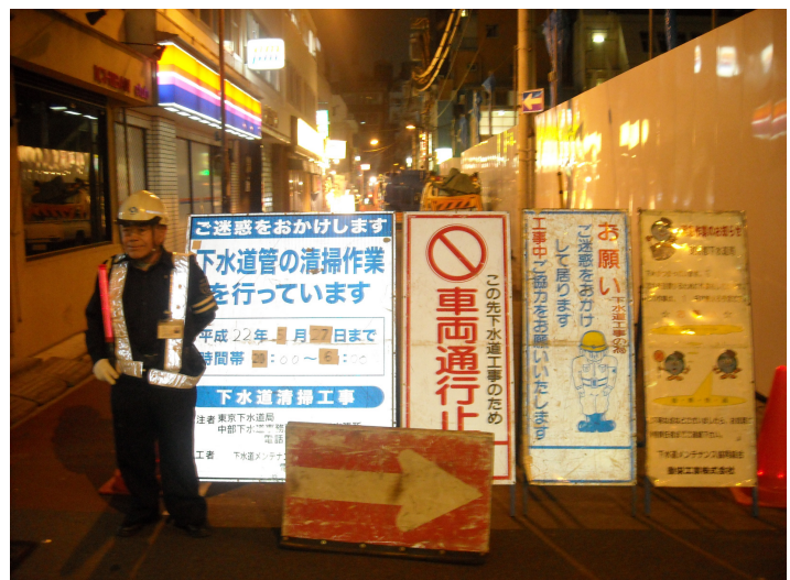
工事に伴う通行止め場所からの、迂回説明
